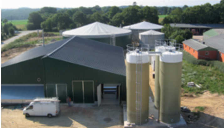
L'unité BIOWATT à Rohan en Bretagne
